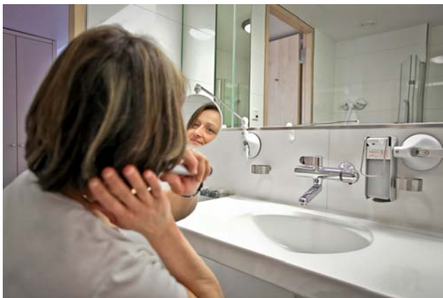
Oder: vorn auf Waschtisch nach barrierefrei DIN 18040-1 mit max. Bediendistanz 400 mm / max. Höhe 1050 mm
